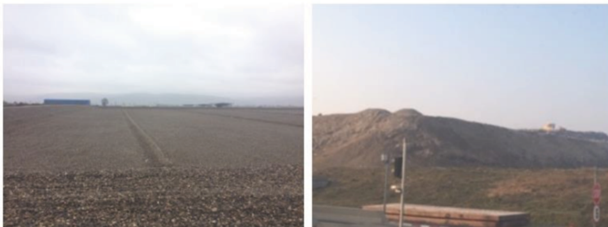
Figura 30: Celula 2 a depozitului conform de la Bacău
