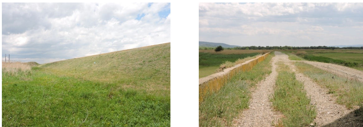
Figura 16: Digul de protecție din vecinătatea ITDCS
