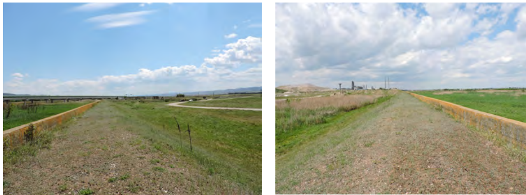
Figura 60. Digul de protecție existent în vecinătatea amplasamentului ITDCS
