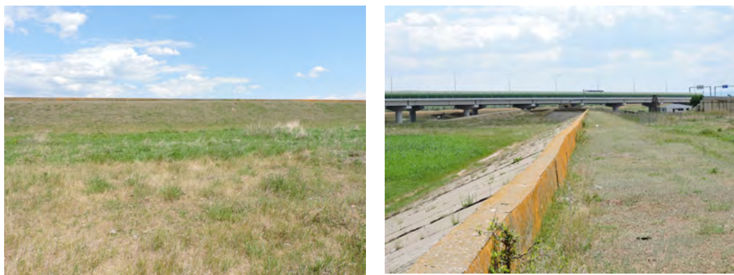
Figura 70. Digul de protecție existent în vecinătatea ITDCS
