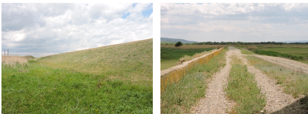
Figura 22: Digul de protecție din vecinătatea ITDCS
