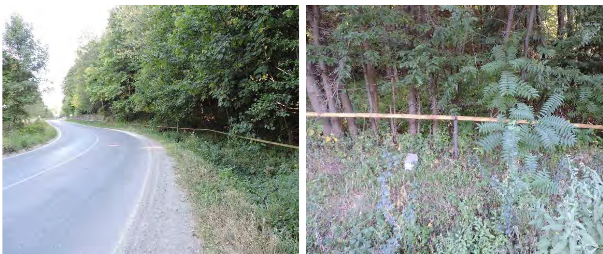
Figura 100. Conductă de aducțiune existentă în zona Tg. Ocna
