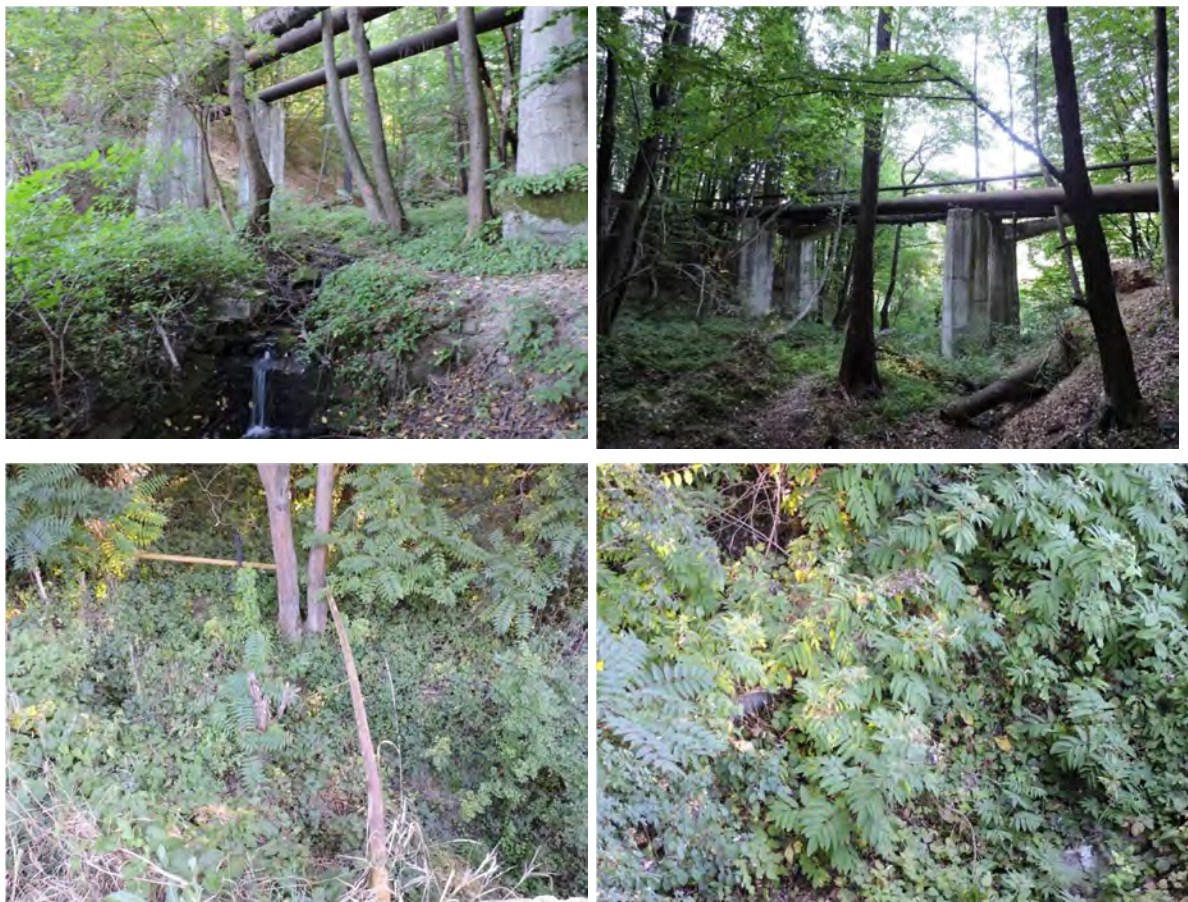
Figura 152. Conducte existente în zona conductei de aducțiune din Tg. Ocna
