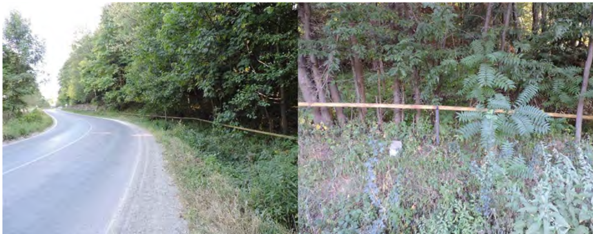
Figura 90. Conductă de aducțiune existentă in zona Tg. Ocna
