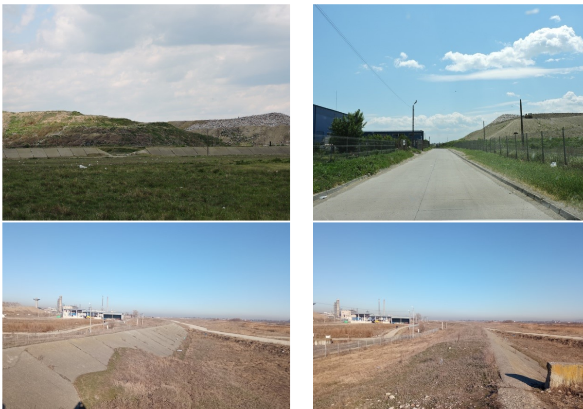
Figura 26. Depozit de deșeuri Bacău existent în vecinătatea amplasamentului propus pentru ITDCS
