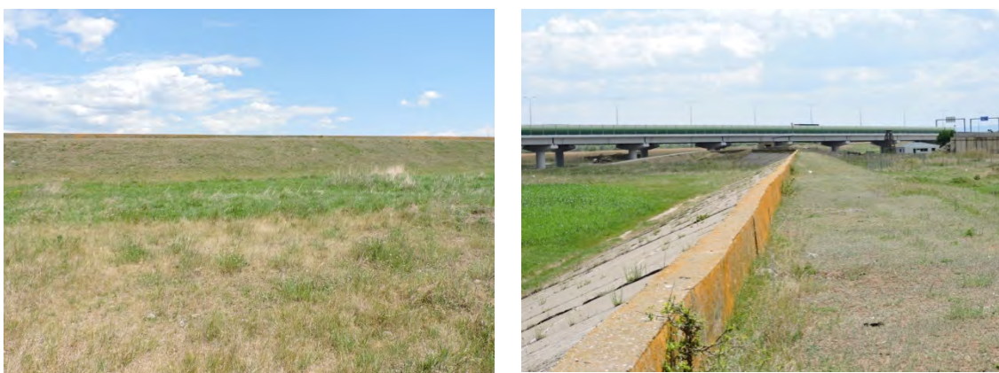
Figura 64. Digul de protecție existent în vecinătatea ITDCS
