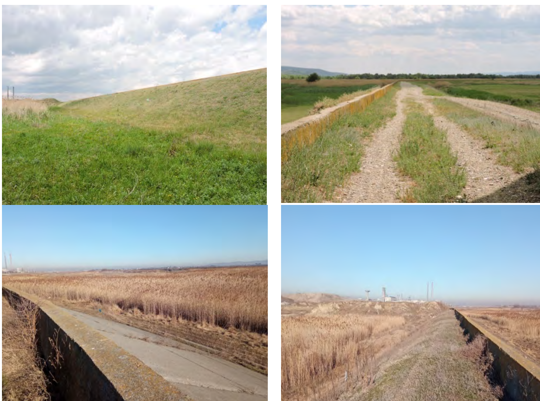
Figura 44. Digul de protecție din vecinătatea ITDCS
