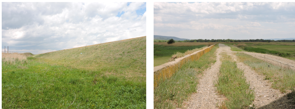
Figura 49. Digul de protecție din vecinătatea ITDCS
