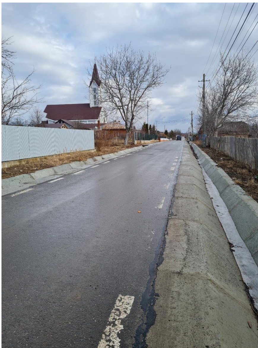
Drum amenajat cu rigole de scurgere betonate, localitatea Traian
